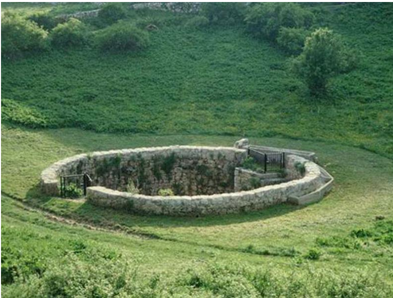
Grande cisterna sotto la chiesa
